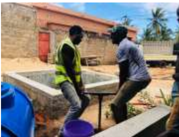
手掘りで掘削中。
