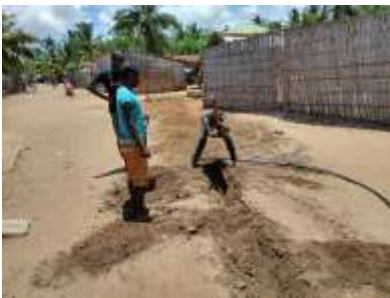
路地から長々と水道管の敷設。
