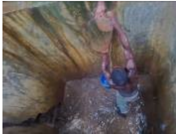
地下タンクの修理
