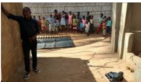
鉄門扉の修理
