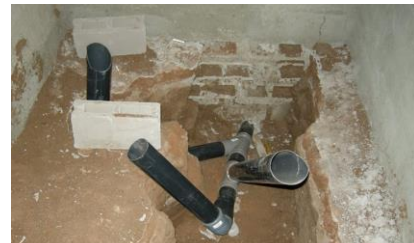
内トイレの配管作業
