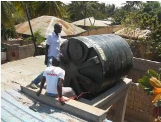
建屋の上に、水タンク（3000L）を設置。
